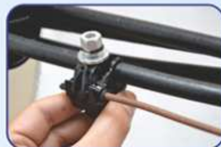
3. Монтаж зажима на магистральный провод
