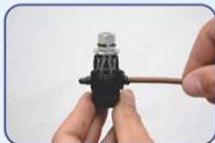
2. Подключение абонентского провода и установка изолированного колпачка
