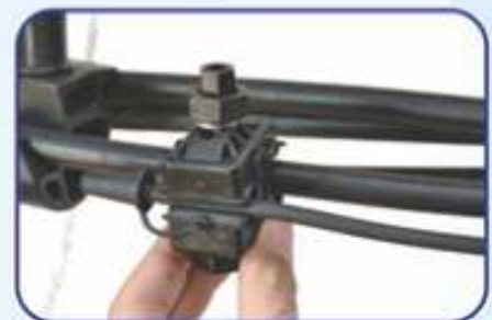
3. Монтаж зажима на магистральный провод
