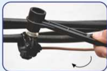
4. Затяжка верхней части головки на зажиме с помощью изолированного ключа OK 13, в направлении по часовой стрелке
